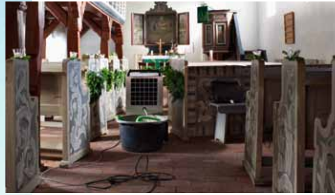
Die Kirche von Lostau während des Hochwassers (links) und kurz danach mit Trocknungsgerät
