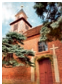
Gefördert: Kirche in Wassersuppe im Havelland
