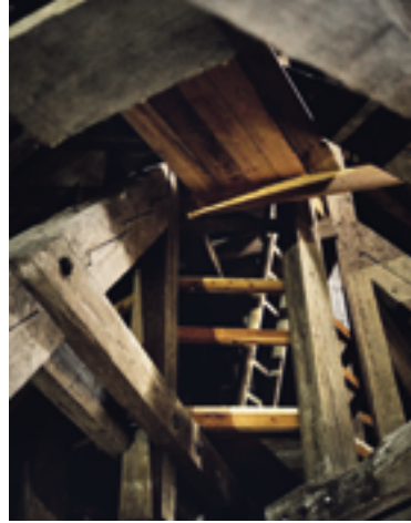
Details des fast 800 Jahre alten Dachstuhls; rechts im Bild sind am Balken die alten Abbundzeichen zu erkennen
