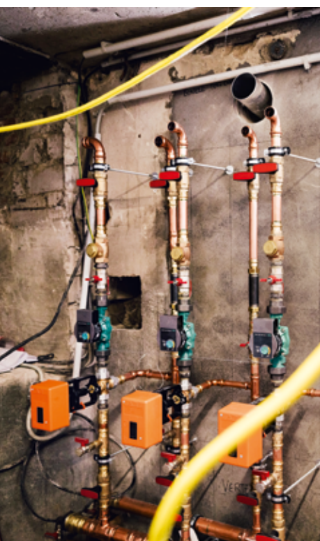
Oben: Kirchbauexperte Manfred Kaminsky mit Dämmmaterial für die Rohre, die unter den Kirchenbänken verlegt werden; darunter: die vernetzt elektronisch gesteuerte Heizanlage im Keller; rechts: Pastor Robert Schnücke-Melcher kann sich für die moderne Heiztechnik begeistern
