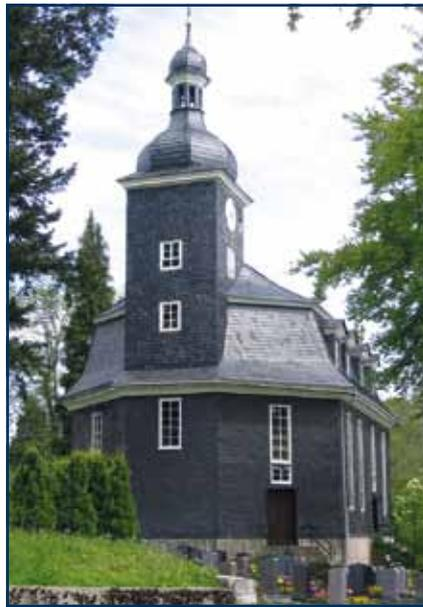
Am 5. November 1741 wurde das barocke Gotteshaus geweiht. Der gestreckte, achteckige Grundriss wird von einem Mansardendach überdeckt. In die Gebäudehülle einbezogen ist der Kirchturm mit quadratischem Grundriss und einer Welschen Haube. Das Dach und die Außenwände sind mit Naturschiefer gedeckt. Weiße Fensterrahmen und Simse gliedern die Fassade.
