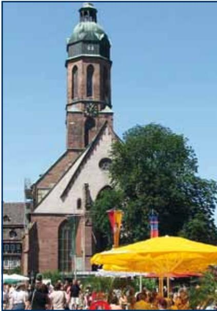
Der Turm der St.-Jakobi-Kirche entstand in der frühesten Phase der Stadtwerdung Einbecks. Er steht am westlichen Ende des Marktplatzes. Die jetzige Kirche wurde ab 1270 als Doppelturmfassade erbaut und im frühen 14. Jh. mit Bauunterbrechung fertiggestellt. 1741 bereits erfolgte eine statische Turmsicherung aufgrund seiner Neigung nach Westen.
