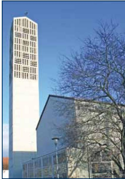
Die Markuskirche ist mit den Baujahren 1957 bis 1958 eine der jüngsten unter den KIBA-Kirchen. Der Form nach bildet sie eine Basilika. Der Glockenturm steht – durch einen offenen Gang verbunden – vom Hauptgebäude abgerückt. Die gesamte Anlage ist in schlichten klaren Formen konzipiert. Damit korrespondiert das Baumaterial Sichtbeton.
