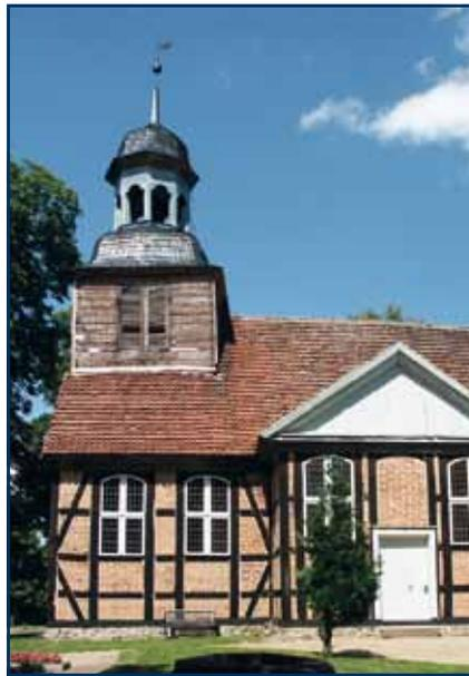
Die unverputzte barocke Fachwerkkirche von 1712 ist mit zwei gleichen Anbauten ausgestattet: Mit dem südlichen Eingangsbereich und dem Gruftbau bildet der Grundriss eine Kreuzform. Der durch zwei dorische Säulen gestützte Innenraum wurde 1832 architektonisch und ornamental vereinheitlicht, die Ausstattung darauf abgestimmt. Große Kirchenfenster lassen viel Licht hinein.
