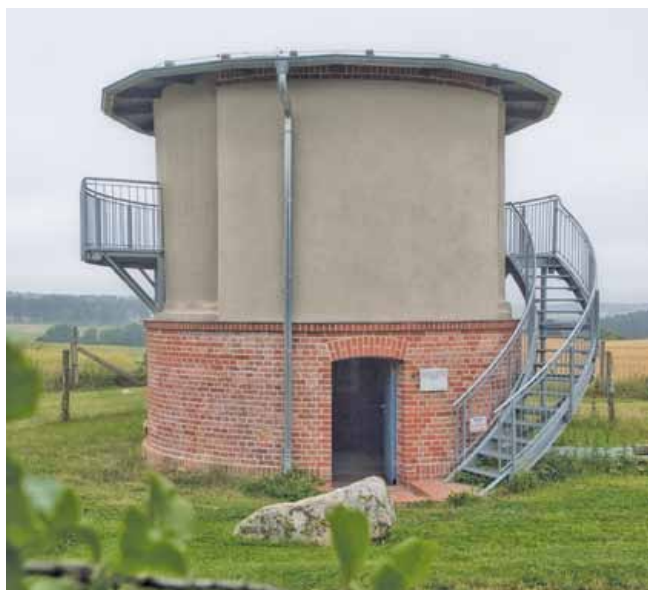
Aussichtspunkt und Informationszentrum „Wasserturm Garrey“
