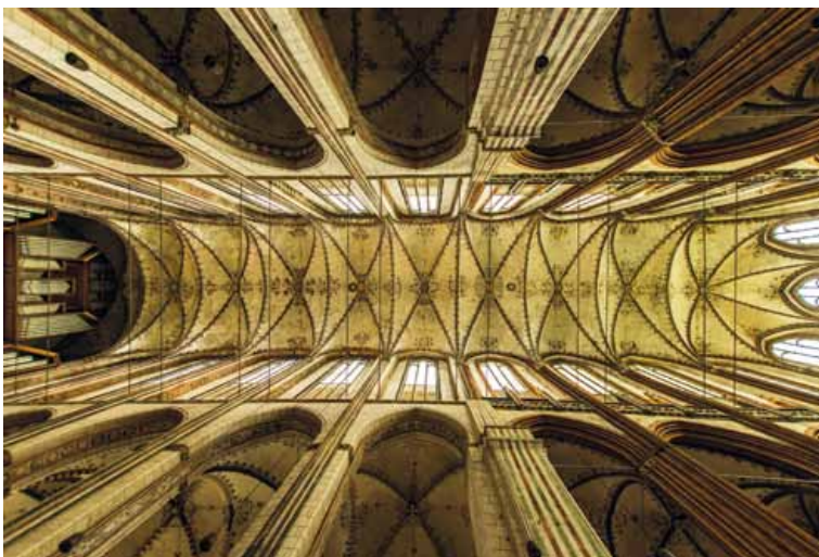
Sonderpreis, Deckengewölbe St. Marien in Lübeck (Volker Sander)
