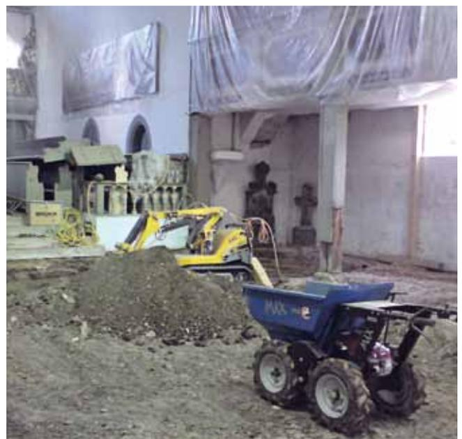
Mit schwerem Gerät: Ausbau des maroden Fußbodens.
