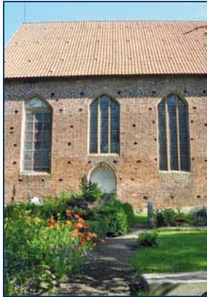
Die Saalkirche wurde auf einem Vorgängerbau von um 1390 errichtet. Sie ist ein einschiffiger Backsteinbau auf einem Feldsteinsockel mit einer barocken Holzbalkendecke. Auf der Nordseite befindet sich eine Sakristei vom Anfang des 19. Jhs. Am Westgiebel steht ein Glockenstuhl von 1868 mit drei Glocken. Die ursprüngliche Farbfassung im Inneren ist übertüncht, aber teils noch erkennbar. Die Kirche besitzt eine Barockausstattung.
