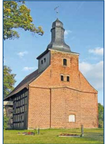
Die seit 25 Jahren gesperrte Kirche wurde zu Anfang des 18. Jh. als Ziegelfachwerkbau über rechteckigem Grundriss errichtet. Der Westgiebel wurde 1865, die Südwand im späten 19. Jh. aus Backstein erneuert. Der nur bis zum Dachfirst des Kirchenschiffs reichende, verbreiterte Turmschaft trägt eine schiefergedeckte zwiebelbekrönter Laterne.
