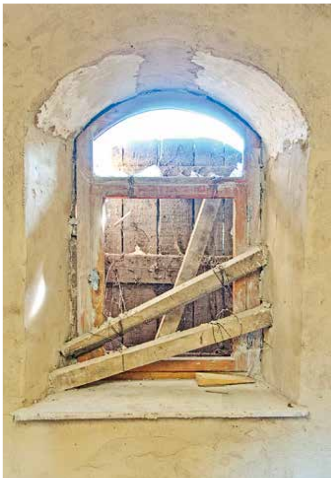
Das Ziel vor Augen, aber noch nicht angekommen: Detail aus der Sakristei
