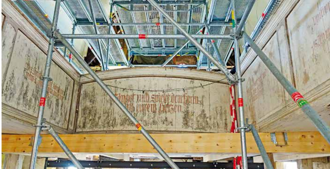
Mehr Metall war nie: Der voll eingerüstete Kirchraum, unten ist eine provisorische Abstützung aus Eisenträgern erkennbar
