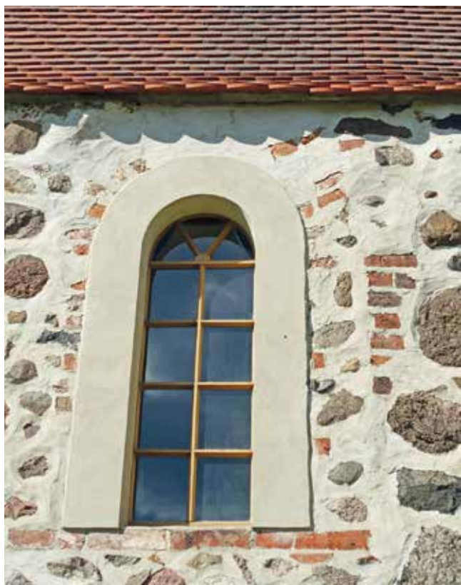
Bald innen so gut in Schuss wie außen: romanisches Fenster in der Südfassade
