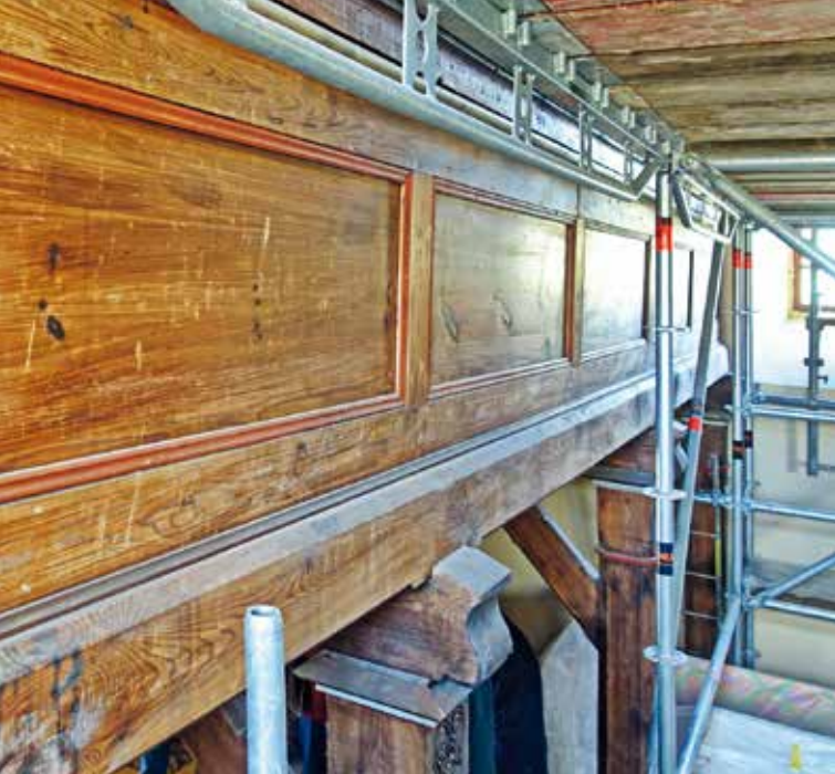
Brüstung der Orgelempore mit Baugerüst
