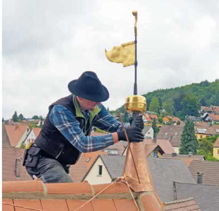
St. Georg Happurg (Bayern) 2021 gefördert, 2025 abgeschlossen
